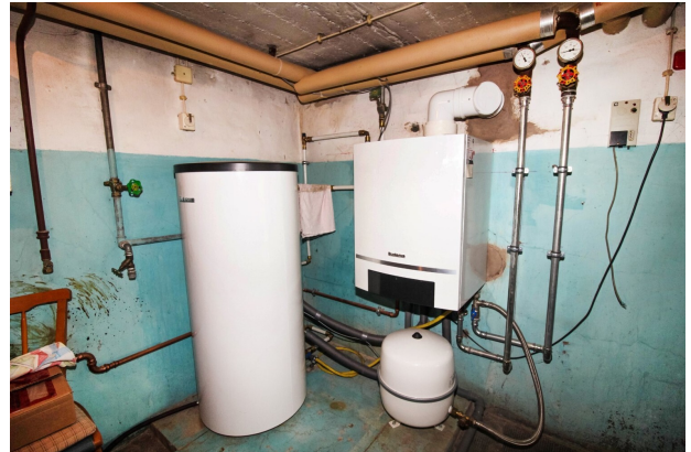
KG Heizung Bild 2
