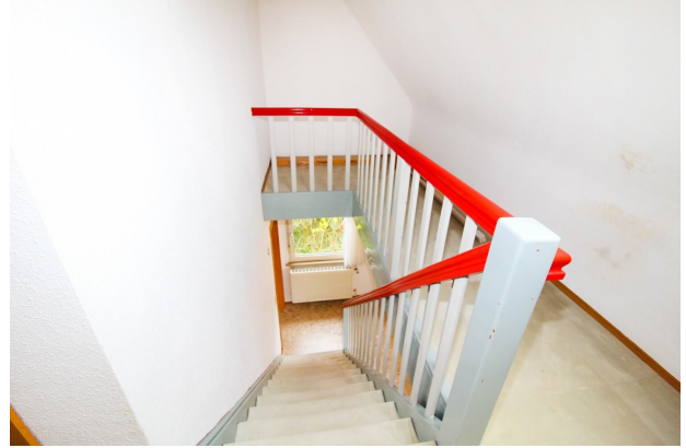
DG Treppe Bild 1
